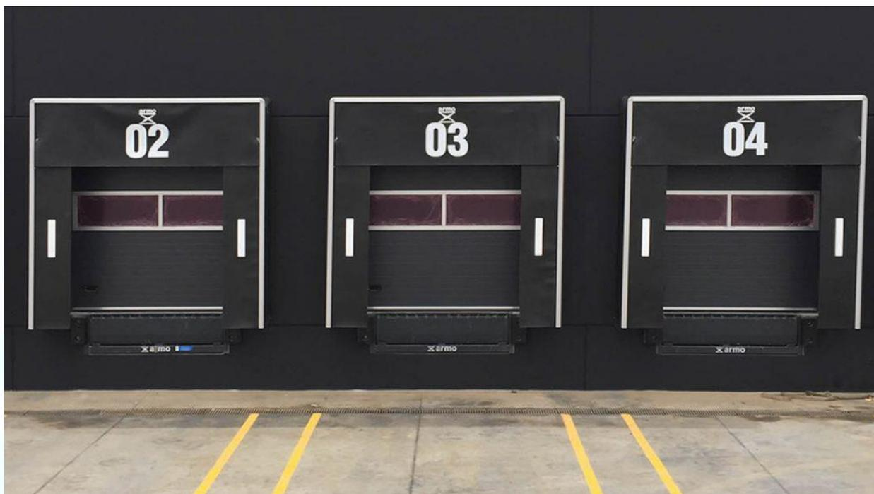
Il **portale isotermico** è necessario per isolare dagli agenti atmosferici e dagli sbalzi di temperatura il Vostro personale ed il contenuto dei Vostri magazzini. Con l'installazione dei sigillanti si ottiene un notevole risparmio energetico.
